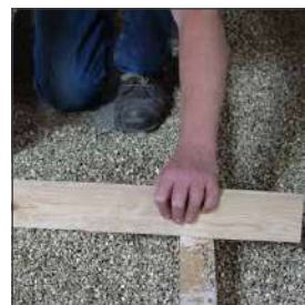
Thermische- brandwerende isolatie
